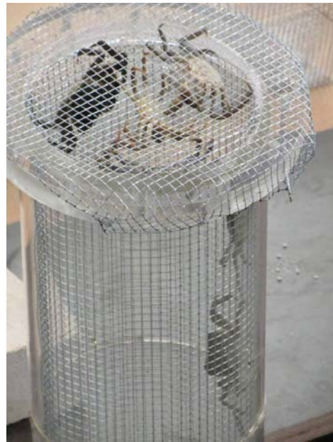
Ableitrohre mit inwändiger Kletterhilfe aus 5 mm-Maschendraht
