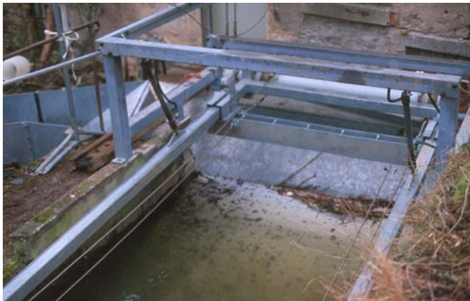
Feinstrechen vor der Wasserkraftanlage Floecksmühle mit Aalen, die die Rechenoberkante in die Bypassrinne hinein passieren
