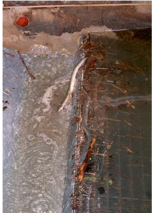
Feinstrechen vor der Wasserkraftanlage Floecksmühle mit Aalen, die die Rechenoberkante in die Bypassrinne hinein passieren
